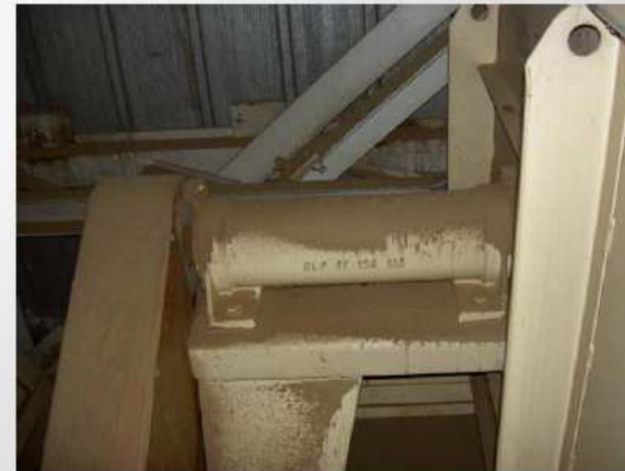
Strati di polvere alimentare su carcassa di ventilatore (P, S)
